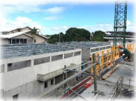
Une fois le sous-sol réalisé, le planning chantier imposait de réaliser d'abord les Villas et ensuite le Collectif, dans le but de pouvoir enchaîner rapidement les Corps d'Etat Secondaire dans ces appartements. La méthodologie mise en œuvre fut la réalisation de voile banché, hormis le noyau ascenseur monté en prémurs, avec des planchers coulés en place pleine épaisseur, coffré grâce à l'outil Peri Gridflex.
